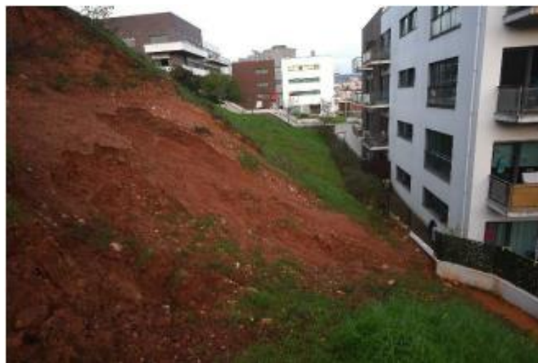
Figure 2: Landslide in Alto da Guarda Inglesa (2020); Source: Diário de Coimbra (2023)
